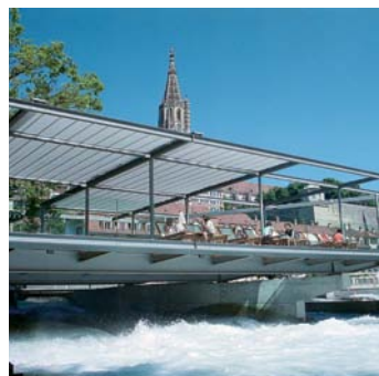
Restaurant Schwellenmätteli Bern
